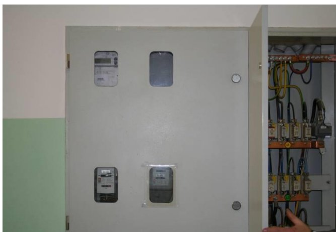
Slika 5.9: Posnetek merilnega mesta
