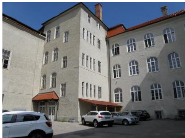
Slika 6.4: Posnetek notranjega atrija zahodna in južna fasada
