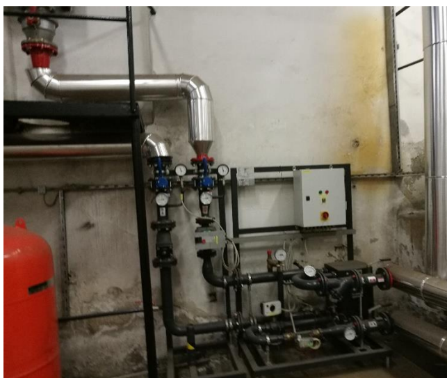
Slika 5.1: Posnetek kompaktno toplotne postaje Vir: lastni vir.
