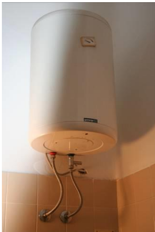
Slika 5.5: Posnetek električnega bojlerja kapacitete 80 litrov in moči 2 kW Vir: lastni vir.
