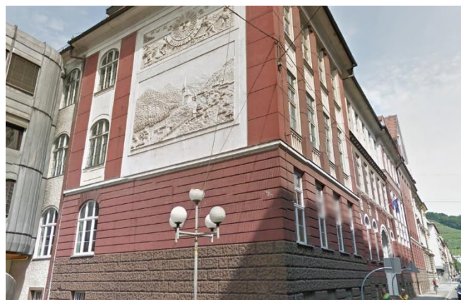
Slika 6.2: Posnetek južne in vzhodne fasade
