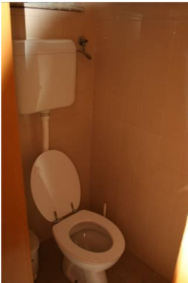
Slika 5.7: Nadometni WC-kotliček brez varčevalne tipke Vir: lastni vir.
